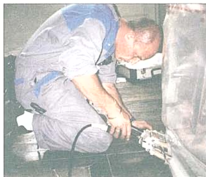
Un traitement effectué in-situ par Hygiène Office. Ici, la dernière phase de l'opération : le scellement des films à l'aide de la pince à thermo-souder.
